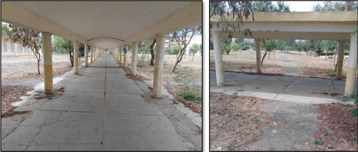
Figure 38 : chemins traversant la galerie piétonne
