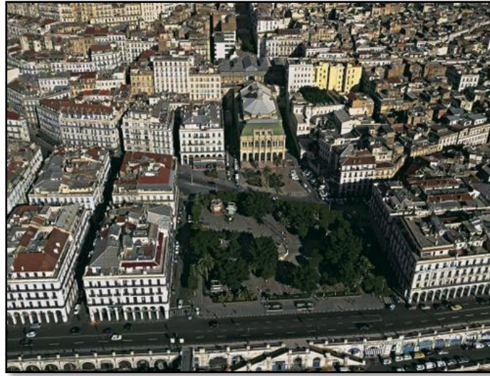
Figure 17 : prise de vue du Square port Saïd, Alger http://algerie.voyage.over-blog.com/article-11229173.html
