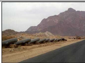
Figure 2.13 : Conduite enterrée à 12 m de l'accotement de RN1.
