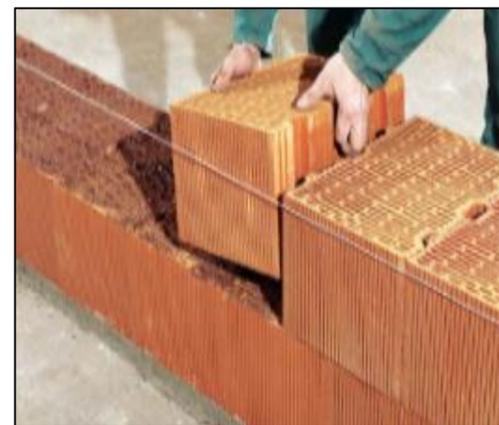
Figure 5.38 : mise en œuvre la brique monomur
