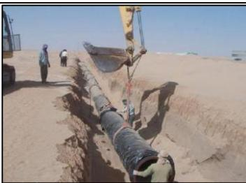
Figure 2.12 : Conduite sur un seul linéaire en écoulement gravitaire
