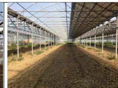
Figure 10 : Serre multi chapelle – préparation du terrain. (photovoltaïque).
