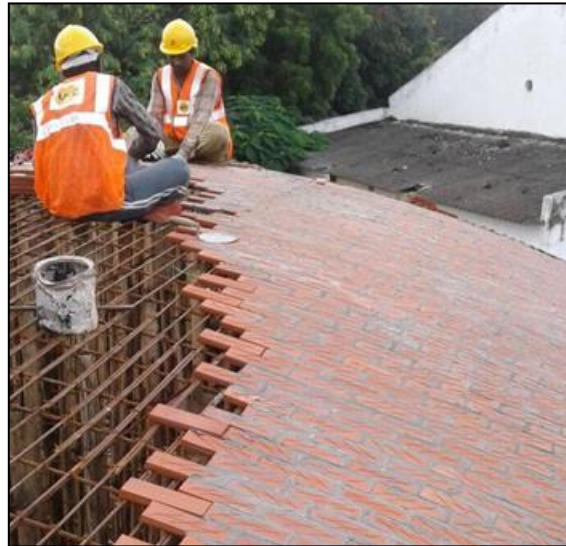
Figure 5.61 : la dépose de la brique sur une nappe de ferrailage Source : https://www.plataformaarquitectura.cl/cl/913404/biblioteca-maya-somaiya-sameep-padora-and-associates/5bbeab2ef197cc3c6a0001fe-maya-somaiya-library-sharda-school-sameep-padora-and-associates-image?next_project=no
