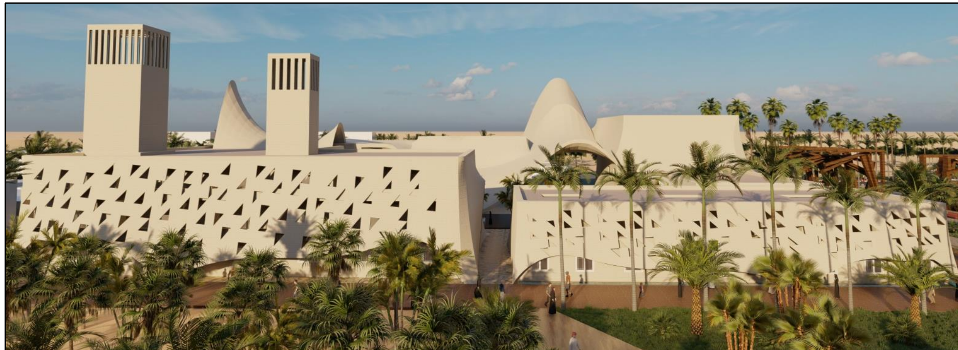
Figure 5.51 : Photo de la 3D de la façade Sud-Est du gite touristique. Source : Auteurs/ année 2020
