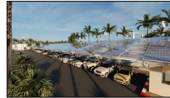
Figure 5.64 : utilisation des panneaux photovoltaïque servant aussi de toiture pour le parking. Source : Auteurs /Année : 2020
