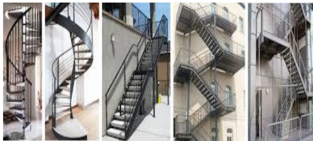
Figure I.6: escalier en charpente métallique
