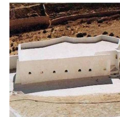
Figure6.36 : mur acrotère Source :algerietele.centerblog.net.
