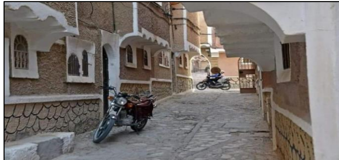
Figure 2.3 : percement sur la façade du Tafilalet a Ghardaïa Source : twitter.com
