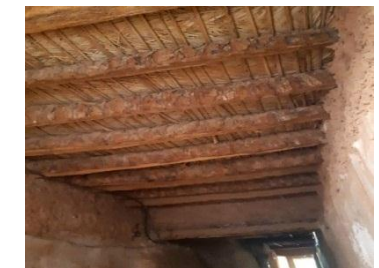
Figure 5.29 : détail du plancher du ksar –source : auteur
