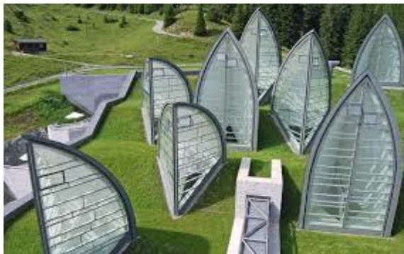
Figure 4.21 : la toiture végétale source : zinco-greenroof.com
