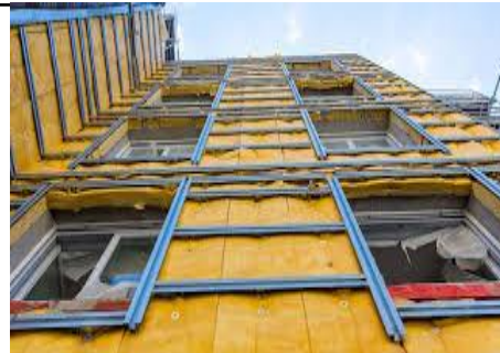
Figure 105 : Exemple de fixation mécanique profilé
