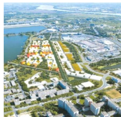
Figure 31 : Vu aérienne Source : https://www.bordeauximm9.com/ecoquartier-ginko-
