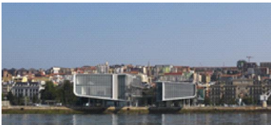
L'image 01 représente la façade Sud du projet, complètement vitrée avec usage de brises soleils verticaux pour profiter de la vue sur mer
