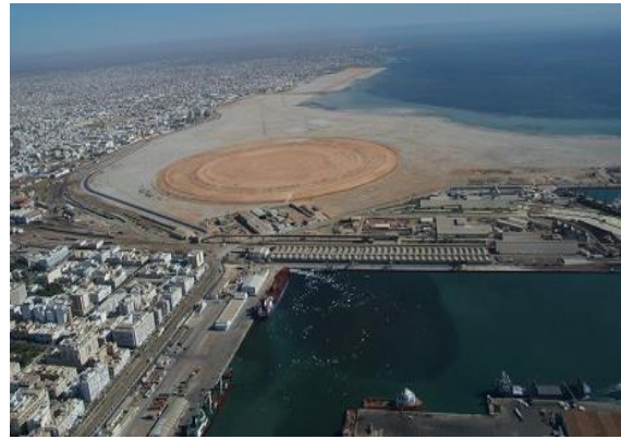
l'image 02 représente les travaux actuels du projet.
