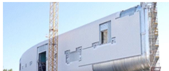
l'image02 représente la façade Ouest, opaque et recouverte des disques en céramique
