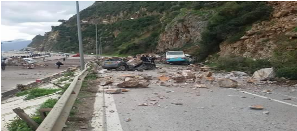
Photo I.3 : Eboulement d'Aokas, Bejaia 2015. [17]
