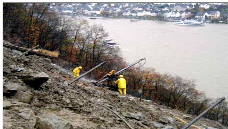
Photo I.8 : Photo d'un Clouage de talus instables. [3]
