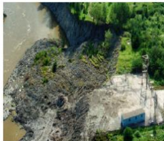
photoI.7 : Exemple d'un glissement rotationnel multiple En bordure de la rivière chicoutimi.[2]
