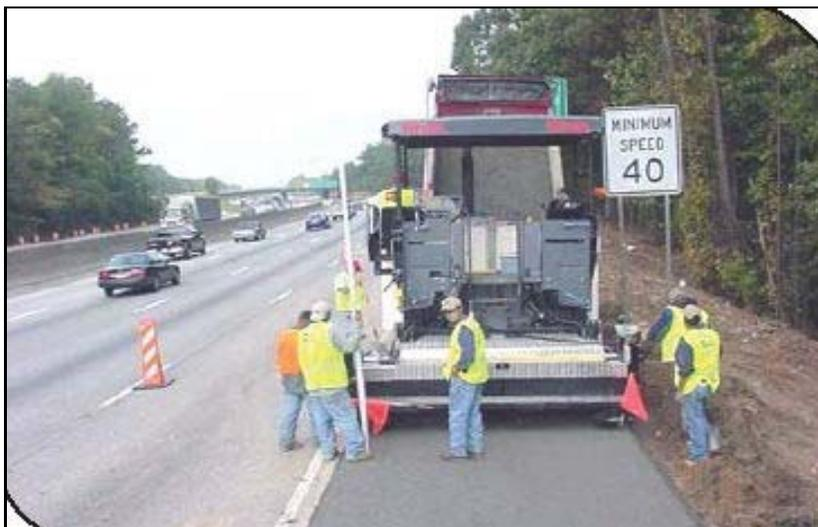
Figure I.1 : Mise en place du BCR en pavage - Atlanta USA. [1].
