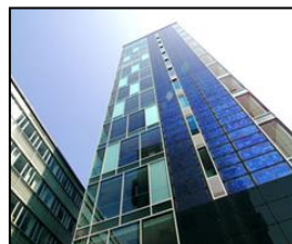
Intégré au bâtiment (sur façade)
