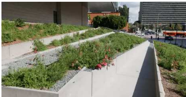
Figure 11: Les plans de jardins dans le palais de justice de Los Angeles
