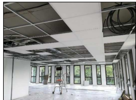
Figure 82: Faux plafond aux plaques au plâtre. Source : google image
