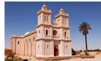
Figure 45: Patrimoine Architecturale : église
