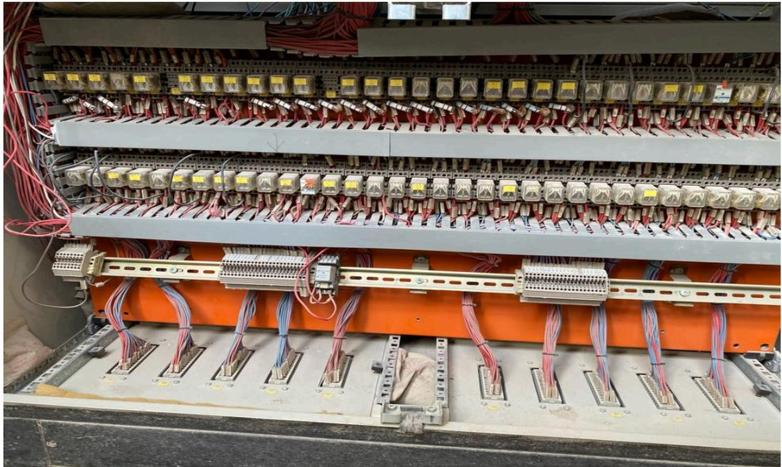
**Figure 1.23** Circuit de commande de la logique câblée [7]
