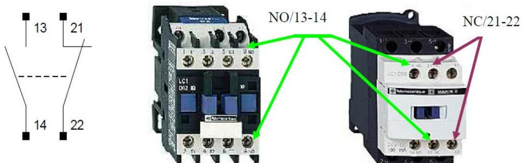
**Figure 3.19** Circuit de commande d'un contacteur [20]
