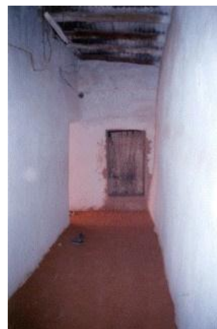
Figure 5-35 : Sqifa dans une maison à Kerzaz
