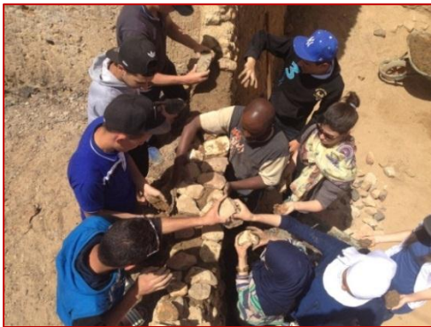
Figure 56: réalisation des murs de pierre avec un mortier de liaison de terre + revêtement de l'enduit sur chantier
