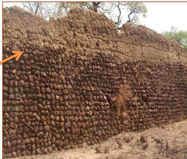
Figure 10 : Détails sur le parfait alignement des pierres. Les bâtisseurs voulurent la muraille droite et lisse.
