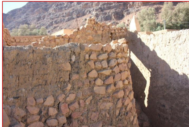
Figure 52: les murs en pierres et terre dans le ksar Adjahil –éditeur-
