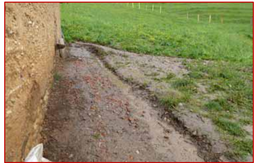
Figure 33 : Exemple d'une pente de drainage réalisée sur une grange à Paladru
