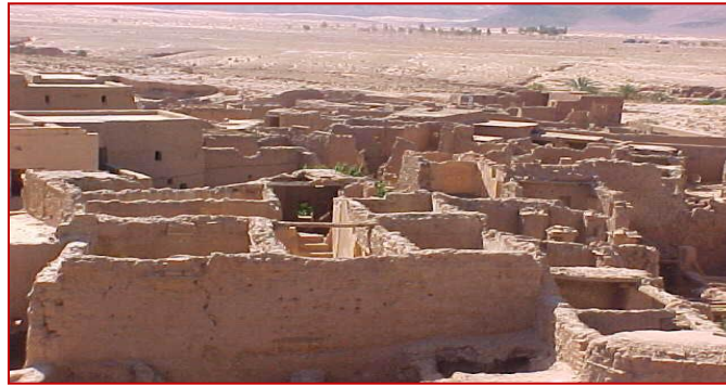
Figure 42: L'horizontalité et la compacité des constructions à Taghit - source Google image -
