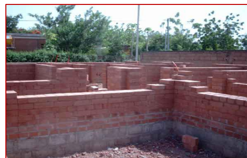
Figure 26: sur chantier (c.belinga)
