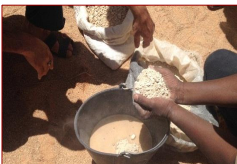
Figure 56: réalisation des murs de pierre avec un mortier de liaison de terre + revêtement de l'enduit sur chantier
