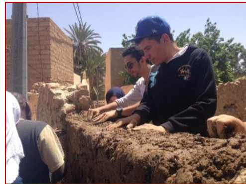
Figure 56: réalisation des murs de pierre avec un mortier de liaison de terre + revêtement de l'enduit sur chantier
