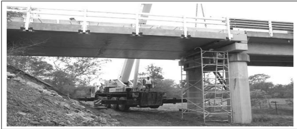
Figure I-47: Installation des premiers composites FRP ‘Australiens’ pour test sur un pont [29]
