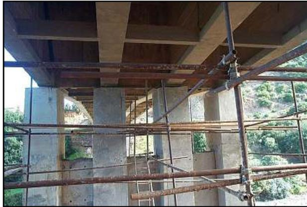
Figure I-52 : Echafaudage des appuis du pont. [10]
