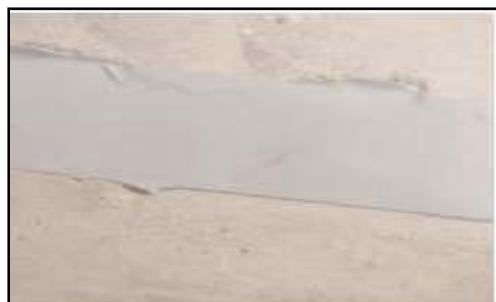
Figure I- 24: Calfeutrement d'une fissure à l'aide d'un mastic. [13]
