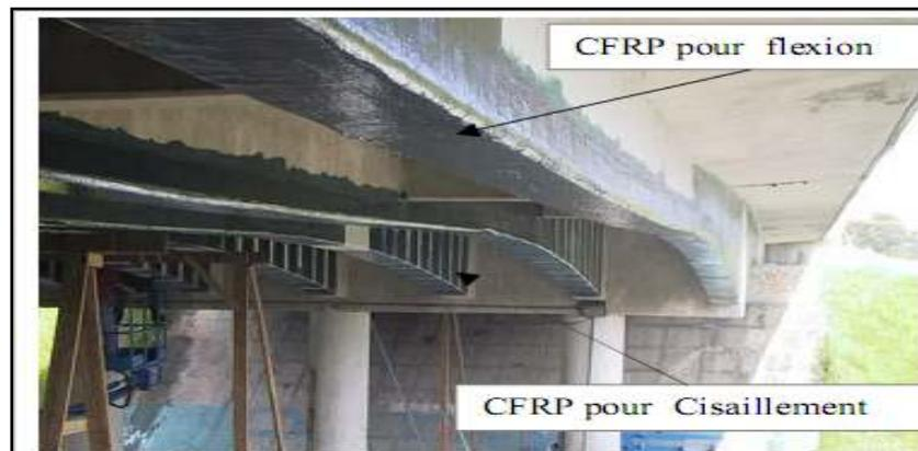
Figure I-56 : Application des CFRP sur le pont. [10]
