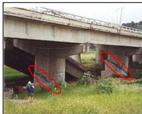
Figure I-6 : Rupture des piles par cisaillement
