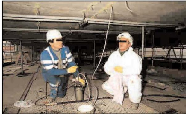
Figure I-22 : Injection de fissures au pont de Châlons-en-Champagne. [13]
