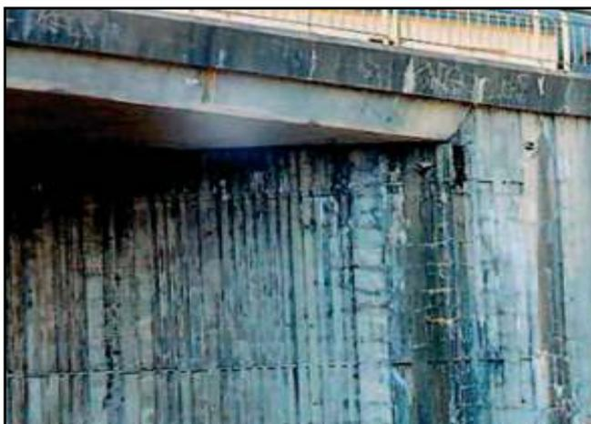
Figure I-11 : Désordres dus à l'alcali-réaction sur un pont. [7]
