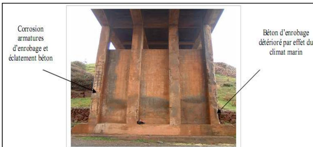
Figure I-51 : Vue des dégradations apparentes sur la pile. [32]
