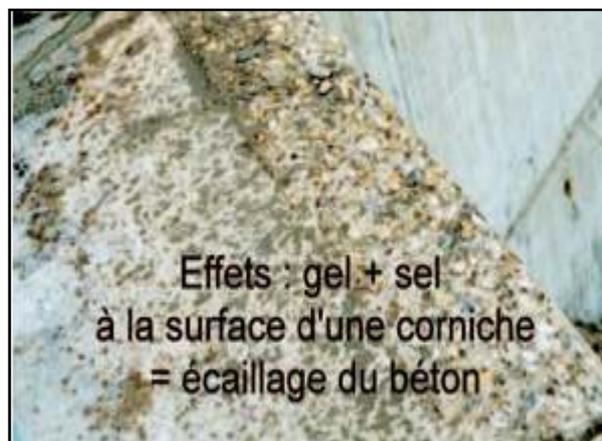
Figure I-8 : Ecaillage du béton d'une corniche.[7]
