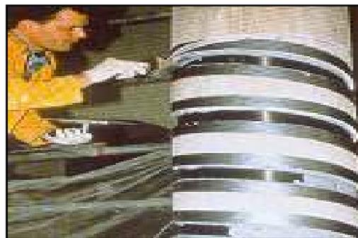
Figure I- 38: Colonne partiellement enveloppée par CFRP. [24]
