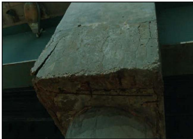
Figure I-10 : Fissuration du béton [9].
