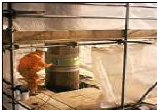
Figure I-37 : Enveloppement total de la pile. [24]
