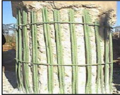
Figure I-26 : Technique de chemisage avec protection des armatures. [19]
