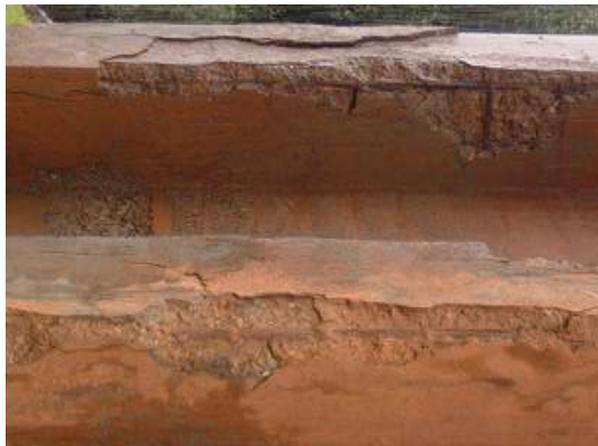
Figure I- 53: Eléments en béton très détériorés avec aciers corrodés. [10]
