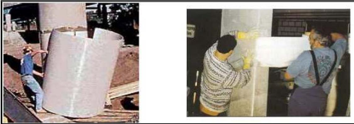
Figure I- 36: Enchemisement avec CFRP préfabriqué (gauche) et in-situ (droite). [23]
