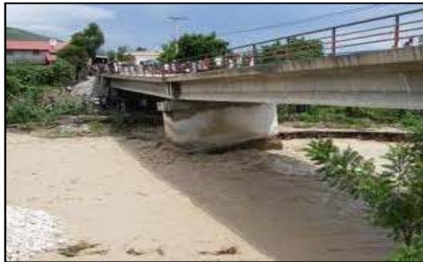
Figure I-4: Affouillement des rivières sur les ponts.
