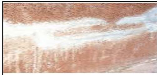
Figure I-23 : Calfeutrement de fissures à l'aide d'un mortier. [13]
