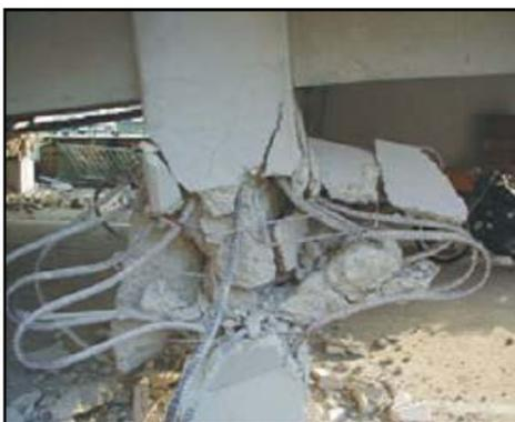
Figure I-5 : Rupture d'une colonne lors d'un séisme Taiwan, 21/9/1999. [6]
