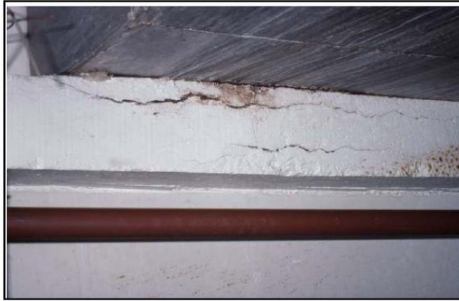
Figure I-9: Eclatement du béton d'une poutre [8].
