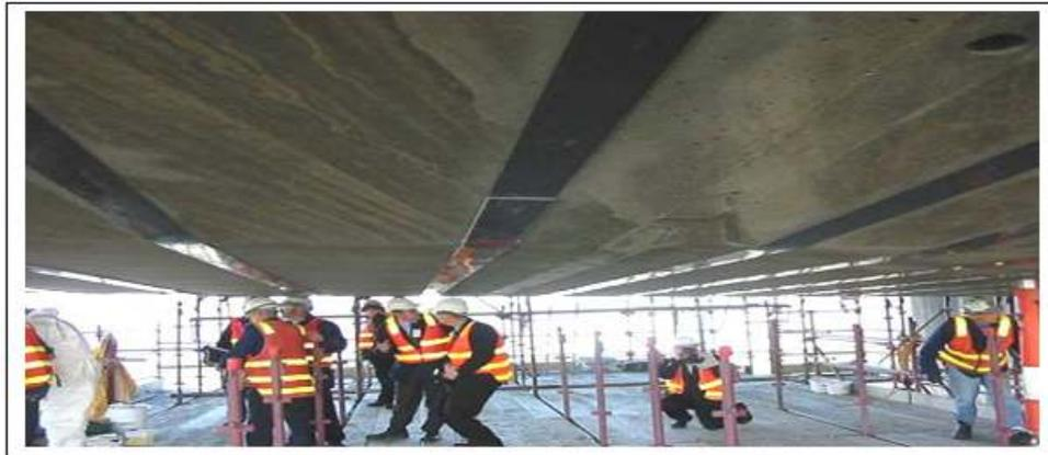
Figure I-48: Inspection du comportement du tablier du pont renforcé [29]
