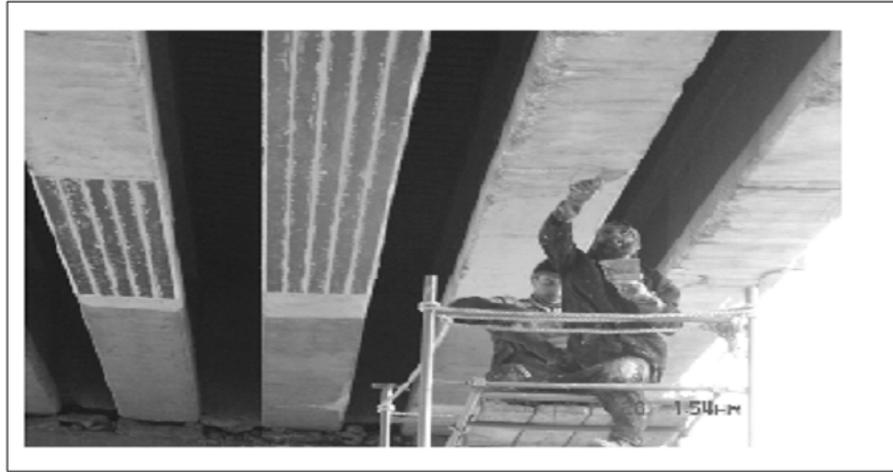
Figure I-50 : Pose de tissu en fibres de carbone sur les poutres du tablier [31]
