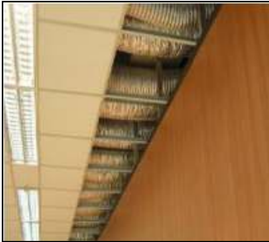
Figure III-57:Faux plafond en plâtre .Source : Google image.
