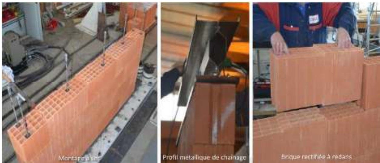
Figure III-56: Mur précontraint démontable ( DOMODELOR) ; source : www.ademe.fr
