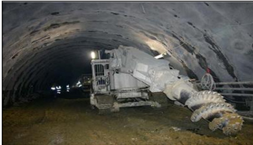
Figure 14: Machine à attaque ponctuelle.
