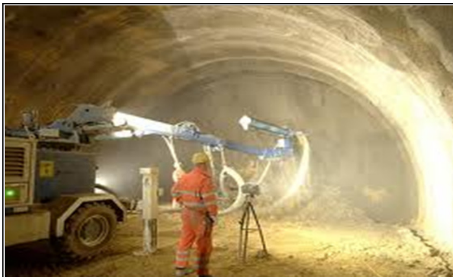
Figure 11: Creusement en demi-section.
