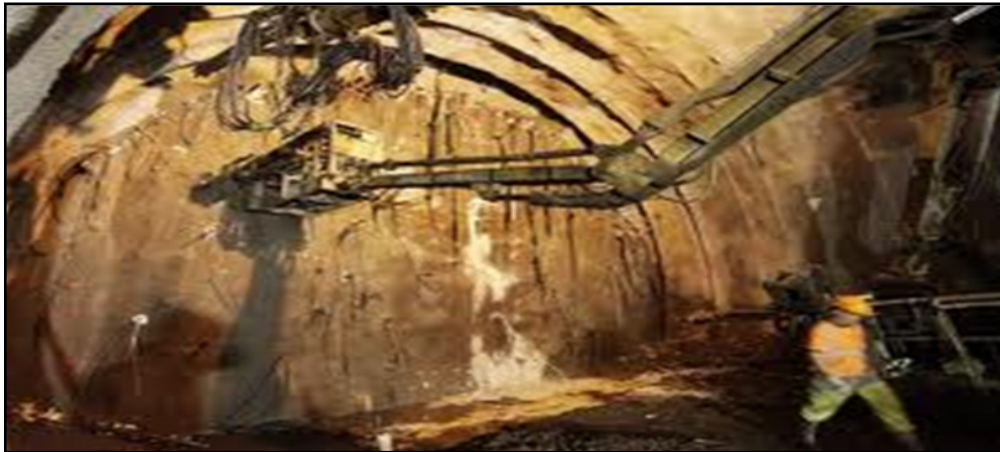
Figure 10 : Méthode à pleine section (tunnel de Tartaguille).
