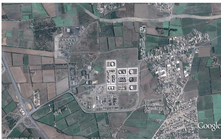
Figure 1-1- Vue aérienne de la raffinerie d'Alger RA1G.
