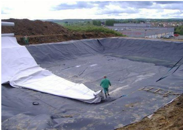
**Figure II.1:**travaux de confinement d'un site pollué [58].
