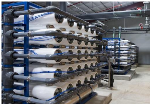
Figure II-2-Station–d’osmose inverse / Coupe d’une membrane d’osmoseur
