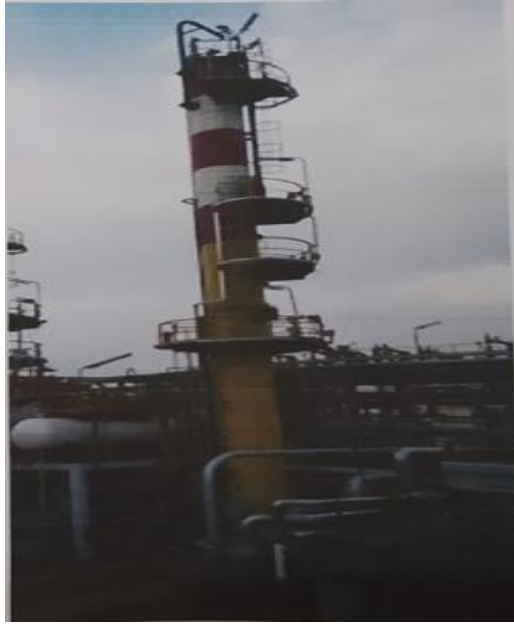
Figure I.5 : section dépropaniseur (C302) de l'unité (U300).
