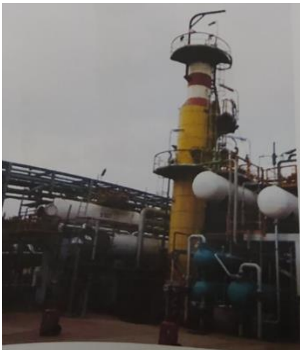
Figure I.4: section dééthaniseur (C301) de l'unité (U300).
