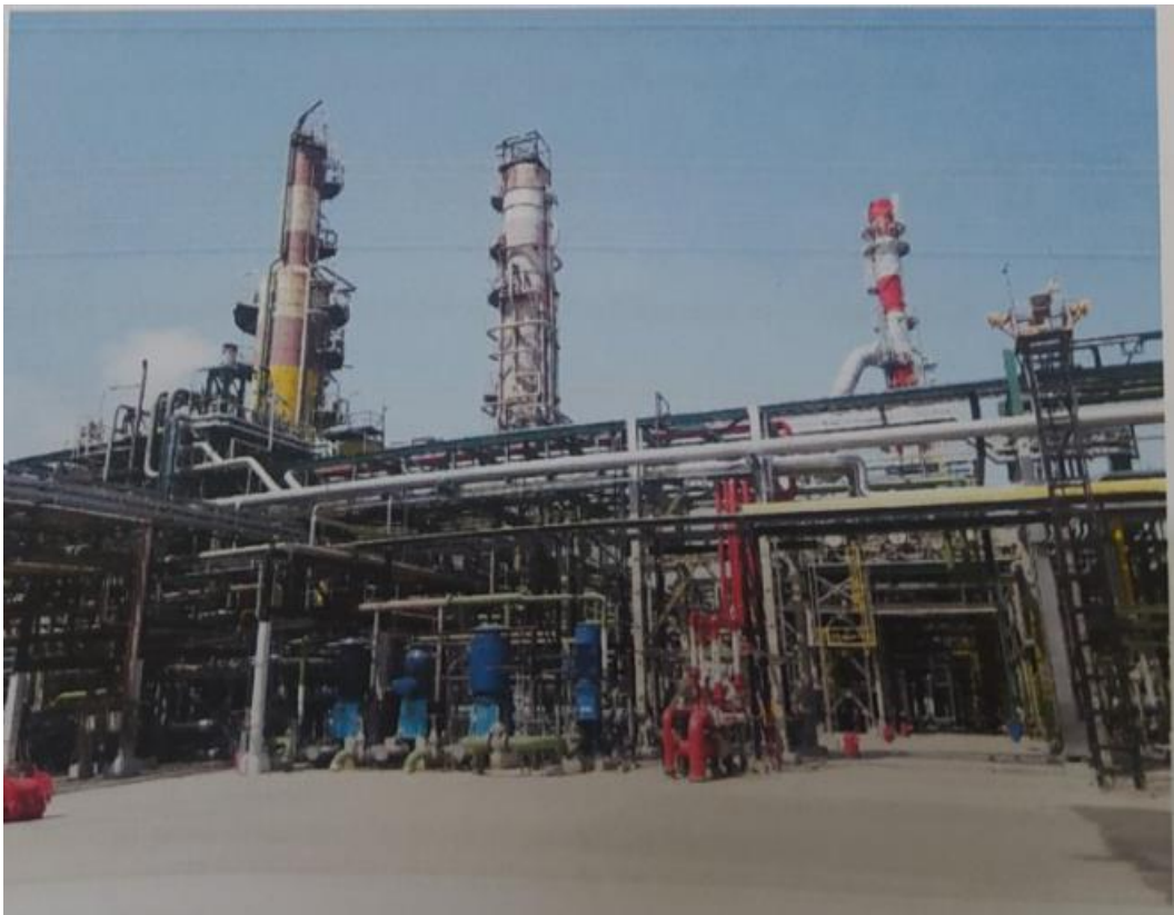
Figure I.2 : unité de distillation atmosphérique (U100)
