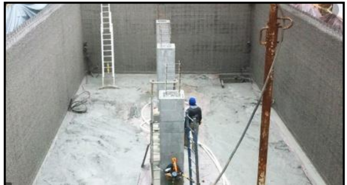
Figure 61 : Mur de soutènement.
