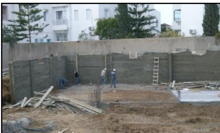
Figure 65 : Voiles en béton armé.
