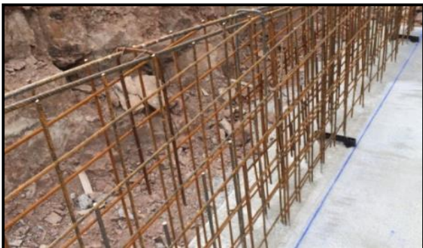
Figure 62 : Mur de soutènement.
