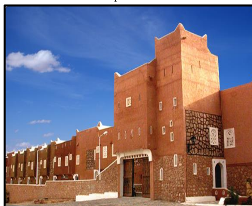
Figure 1.35: Mur de limite du ksar Tafilelt. Source : http://tafilelt.com/site/
