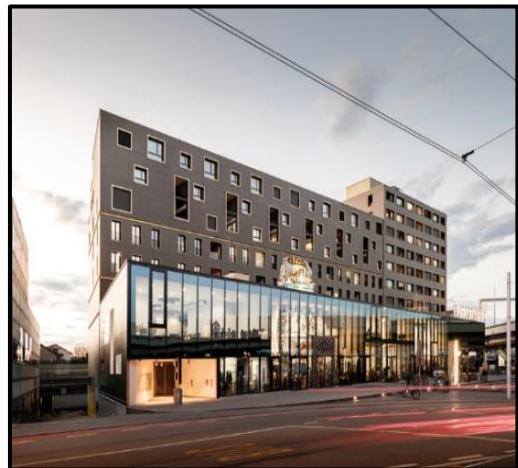
Figure 2.20 : Le centre Multifonctionnel Europlatz. Source : https://archpaper.com/ .
