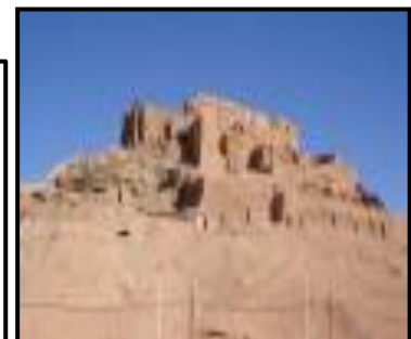
Figure 4.11 : Patrimoine Architectural du Ksar d'El-Meneaa. Source : Egis 2012.mission A
