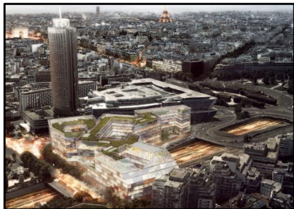
Figure 2.7 : Un immeuble-pont Porte Maillot
