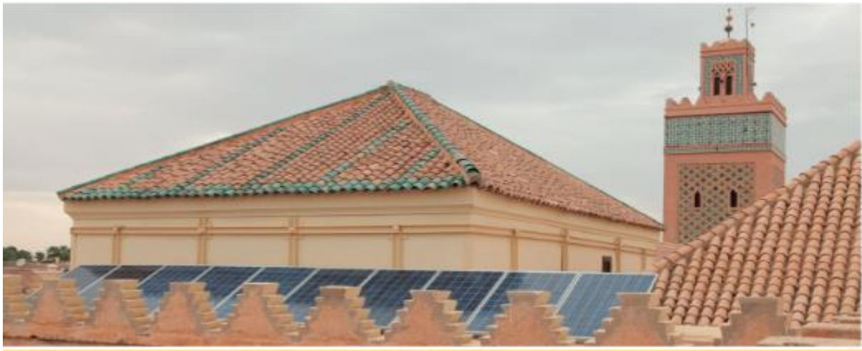
Figure 1-2 La mosquée Moulay Yazid à Marrakech a été équipée de panneaux photovoltaïques, de chauffe-eaux solaires et de lampes LED en 2016[2]
