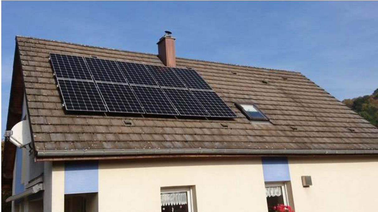
Figure 0-14:pose des Panneaux PV.
