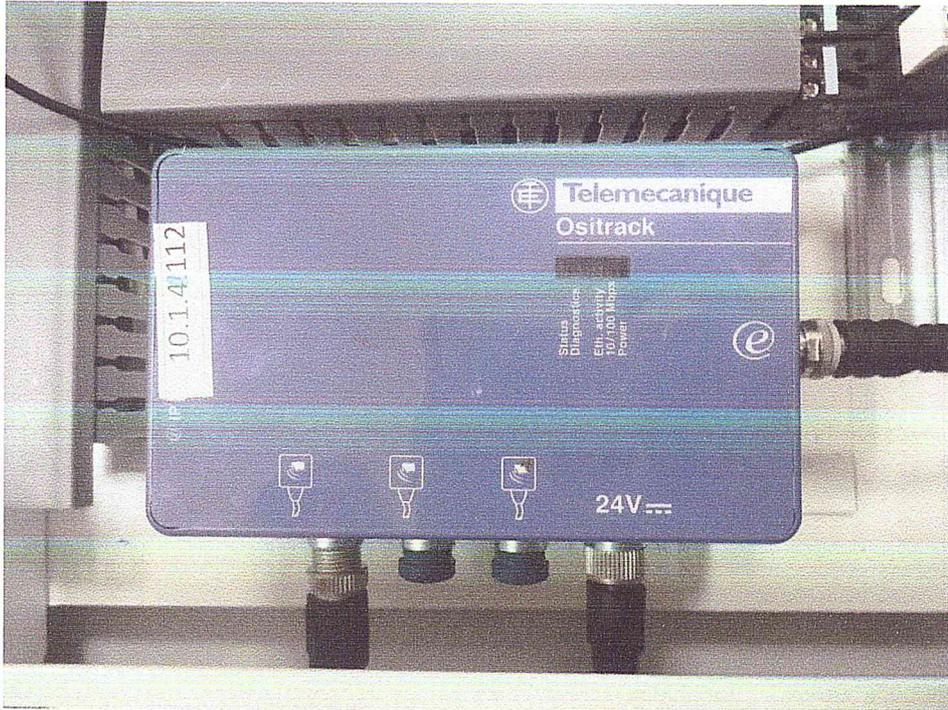
FIGURE 59 – La boîte Ethernet Ositrack XGS Z33ETH.
