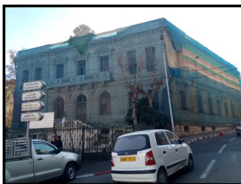
Figure III.5.13 photo de l'ancienne préfecture transformée en musée marin
