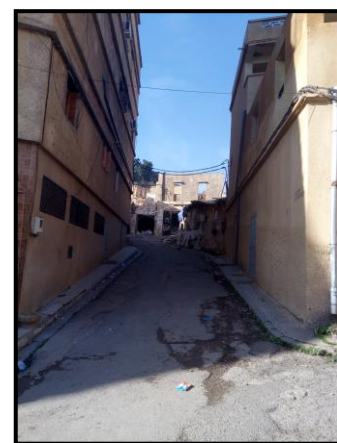
Figure III.5.36 Photo de la maison actuellement
