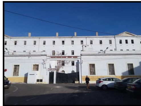
Figure III.5.18 photo du l'hôpital boudens Source : photo prise l'auteur du mémoire le 24/12/2018
