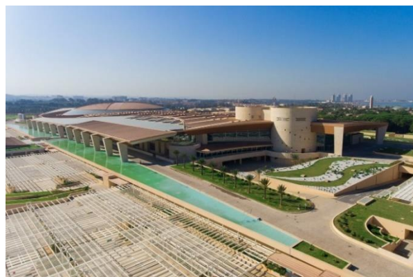
Figure 2.10 : Vue sur Centre International des Conférences d'Alger (CIC).
