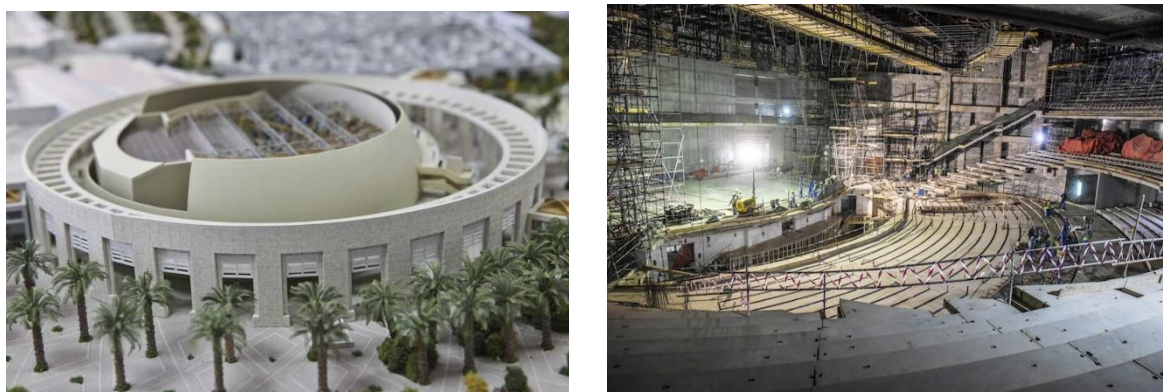
Figure 2.25 : Montre la structure et les matériaux utilisés dans le Centre des congrès et des expositions d'OMAN.
