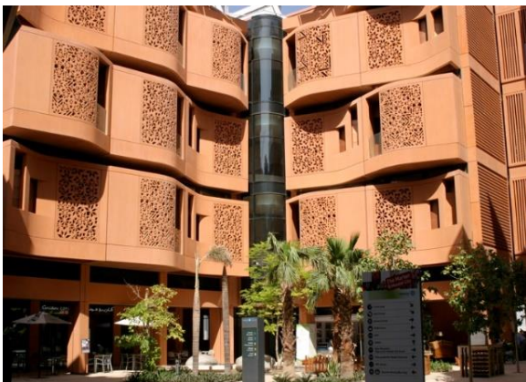
Figure 57 : montre la façade de masdar cité.
