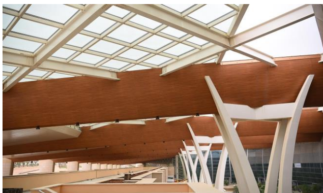
Figure 2.16 : la structure de Centre International des Conférences d'Alger ( CIC ).
