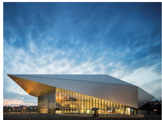
Figure 2.31 : Une vue de face de Centre de congrès swisstech.
