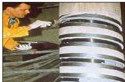
Figure I- 24 : Colonne partiellement enveloppée par CFRP [16]
