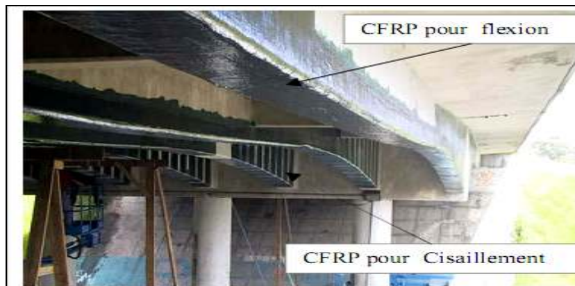
Figure I-38 : Application des CFRP sur le pont [5]
