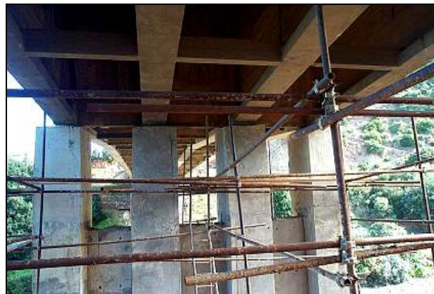
Figure I-36 : Echafaudage des appuis du pont [5]
