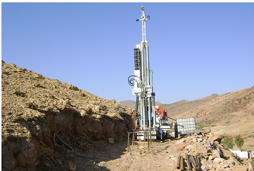
Figure 79 : Photo de prélèvement de sondage carotté.
