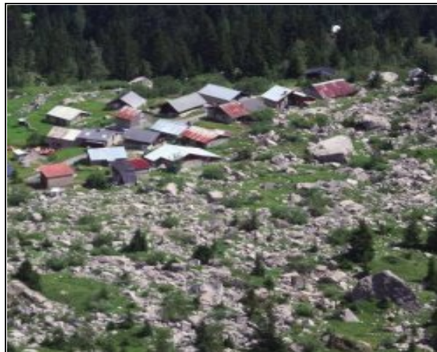
Figure 3: Éboulement sur un village construit au pied de falaise.
