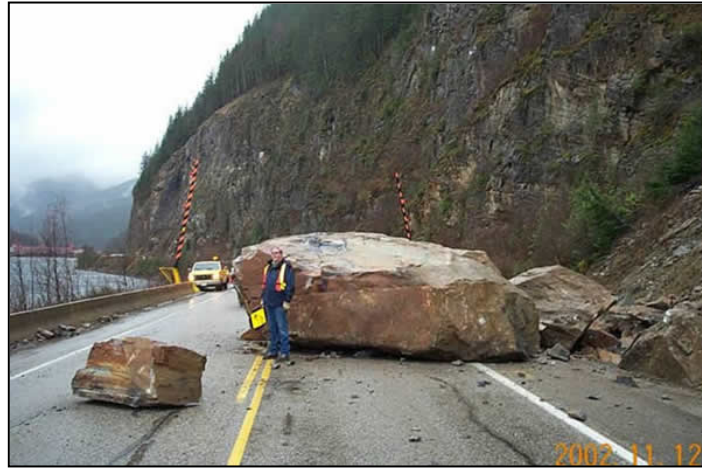
Figure 2: Chute de pierres et de blocs.
