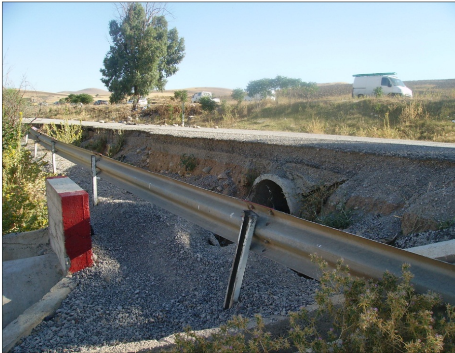
Figure 77 : Photo de l'ouvrage hydraulique.
