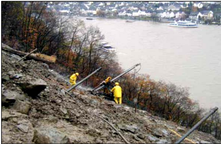
Figure 64 : Clouage de talus instables.
