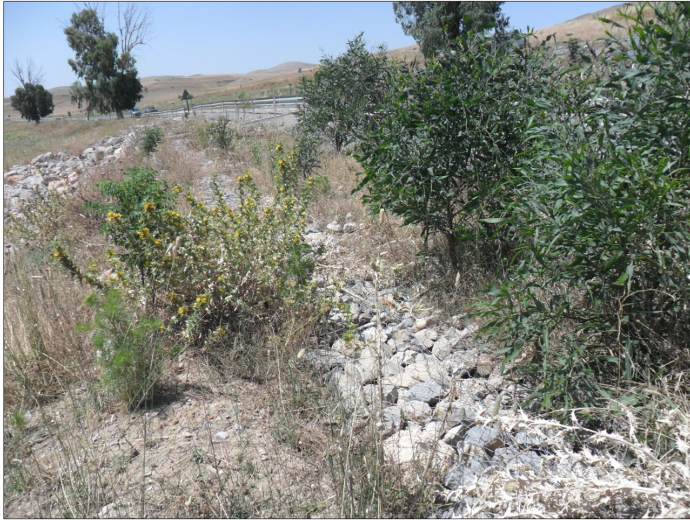
Figure 75 : Photo du talus aval de la route.
