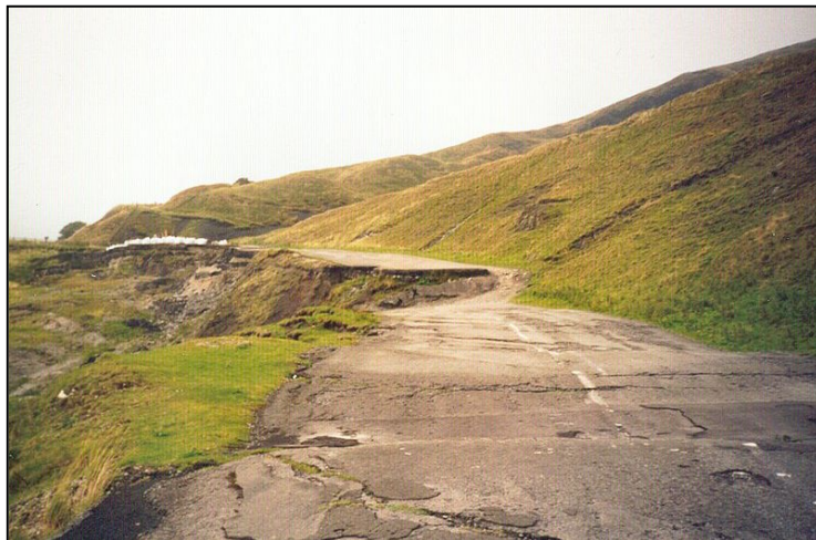
Figure 12: Glissement de terrain ayant emporté des pans de route.
