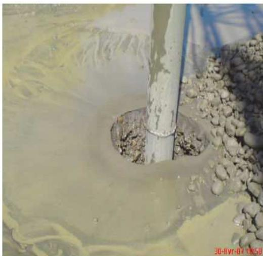
*Figure 1.3.7 : Phénomène de liquéfaction local ( Site : barrage Kissir- Jijel)*
