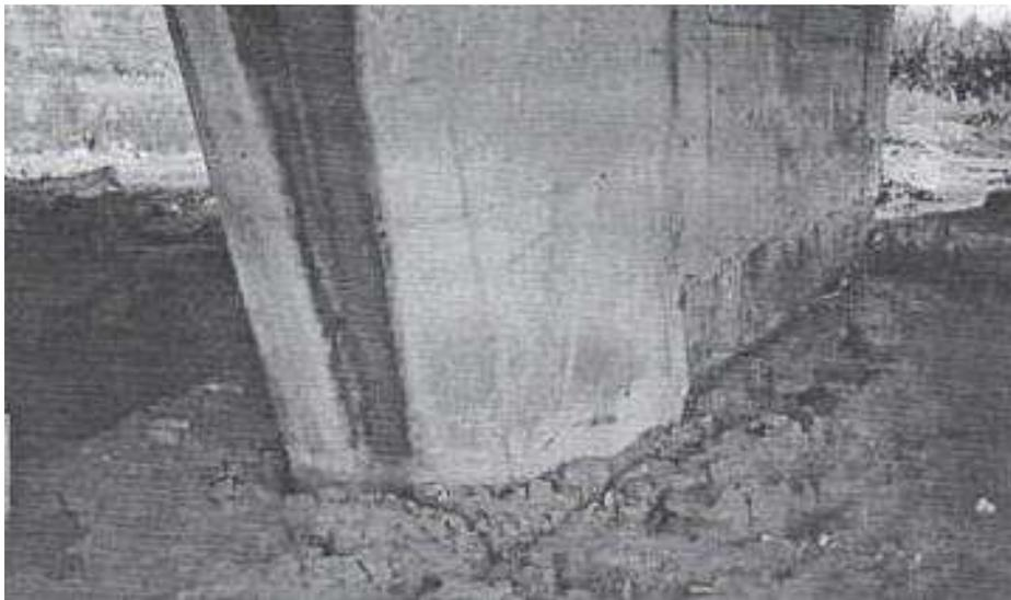
*Figure 1.1.7 : Soulèvement des structures (Taichung, Japon 1971)*
