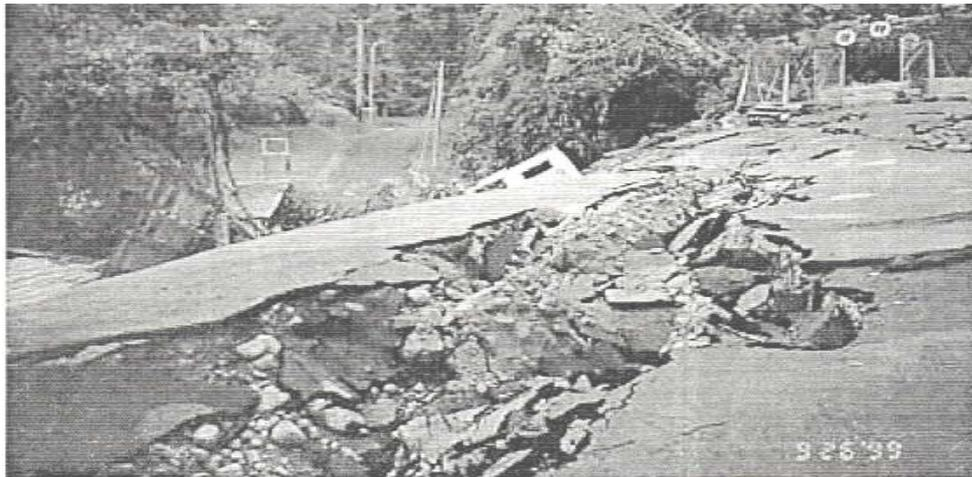
*Figure 1.1.4 : Détérioration du réseau routier (Yualin, 1999).*
