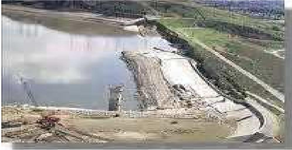
*Figure 1.1.6 : Rupture de barrage ( San Fernando, 1971)*
