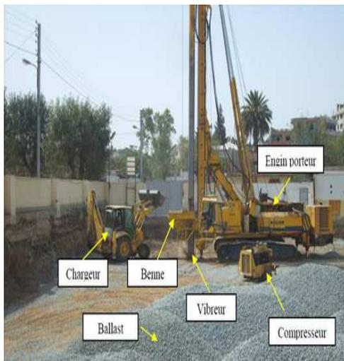
Figure 1.3.4 : Exemple de vibreur
