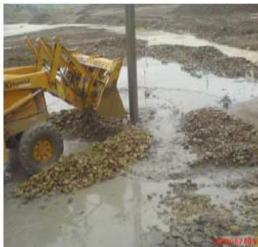
*Figure 1.3.8 : Remplissage du trou par le ballast ( Site : barrage Kissir- Jijel)*
