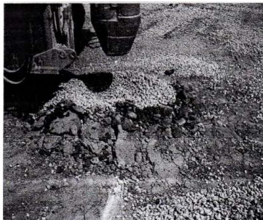
*Figure. II.14. finition d'une colonne*
