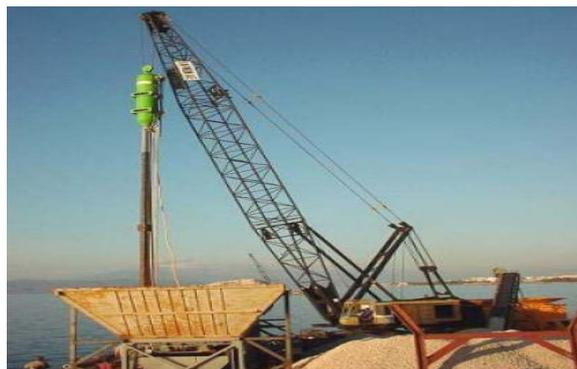
*Figure I.23. Atelier de réalisation de colonnes ballastées en mer*
