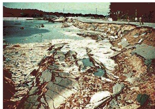
*Figure .I.8 : Glissement des terrains en pente, exemple glissement par liquéfaction du corps d'un remblai au séisme Guatemala (1976). [4]*
