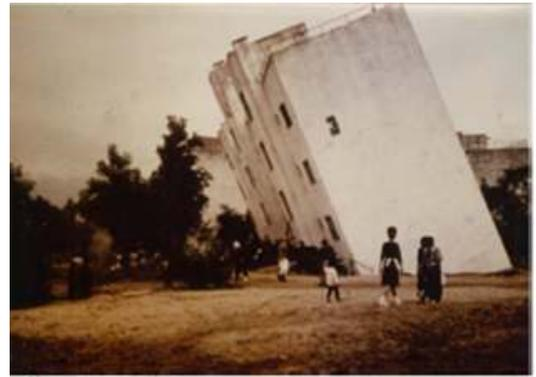
*Figure .I.7 : Perte de capacité portante du sol de fondation, exemple basculement d'un bâtiment de 5 niveaux du à la liquéfaction au séisme Niigata (1964). [4]*
