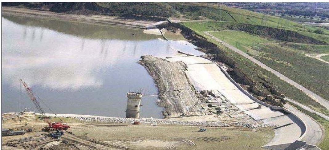
*Figure .I.14 : Effondrement se manifeste en surface d'un barrage, exemple séisme de San-Fernando, 1971.*
