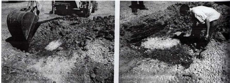
*Figure II.15. Dégarnissage d'une colonne*
