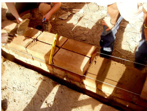
Fig.III.81 : construction d'un mur en BTCS Source : https://www.lemoniteur.fr/article/toiture-terrasse-points-singuliers-en-images.1361249
