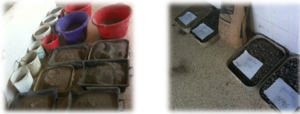
Figure 3.15 : Préparation des granulats pour le coulage
