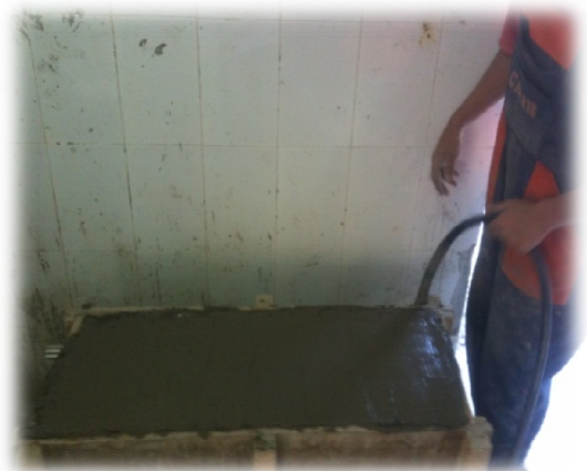
Figure 3.17 : Vibration du béton
