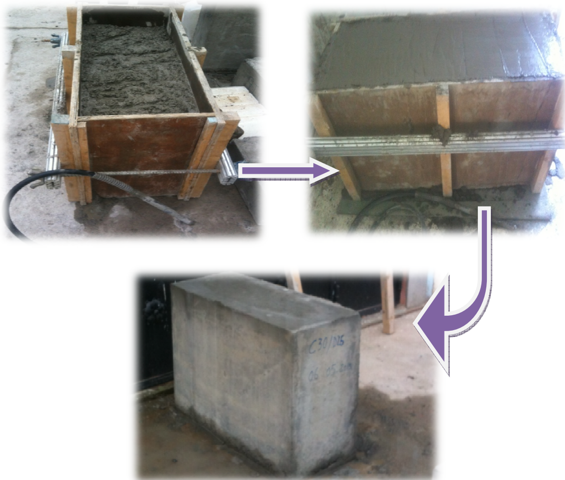
Figure 3.20 : Décoffrage des blocs
