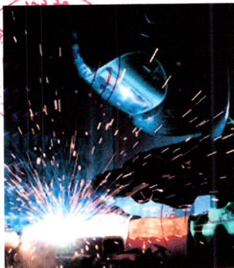
Fig. (I.3) .Soudage à l'arc avec électrode fusible sous flux gazeux
