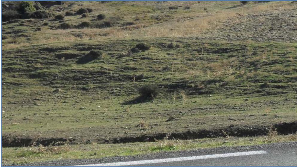
Photo 4.6: Zone de fluage au niveau du talus aval de la chaussée
