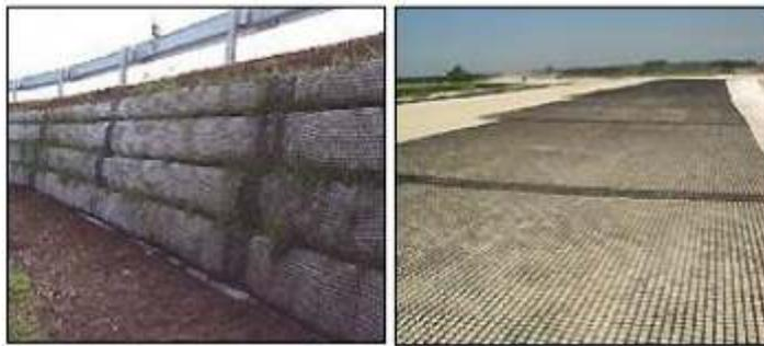
Figure 3.12: Renforcement par géosynthétique
