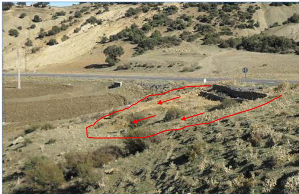
Photo 4.3: Vue générale du glissement, avec les gabions de confortement
