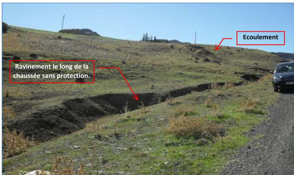
Photo 4.7: Ravinement dû à un écoulement sans protection ni système de drainage
