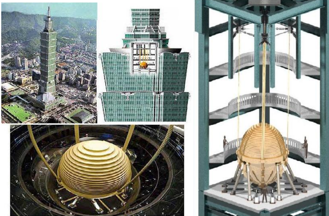
Figure 1.16 : TMD pendulaire au sommet de la tour de Taipei 101.
