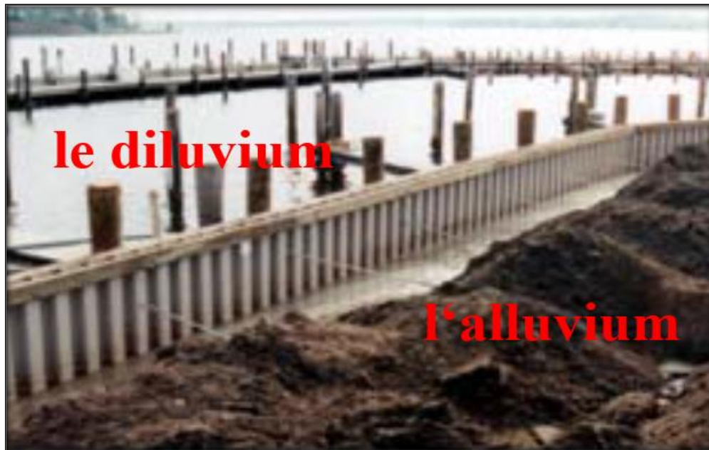
Figure I.23 : Le barrage de sous-surface de Senbaru
