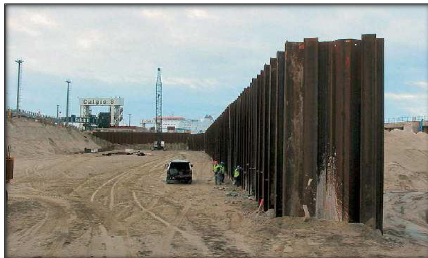
Figure I.21 : Les piles de tôle d'acier (Les palplanches en acier)
