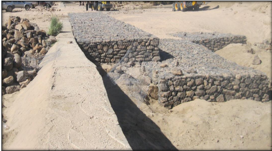
Figure I.16 : La tête du barrage de sous-surface
