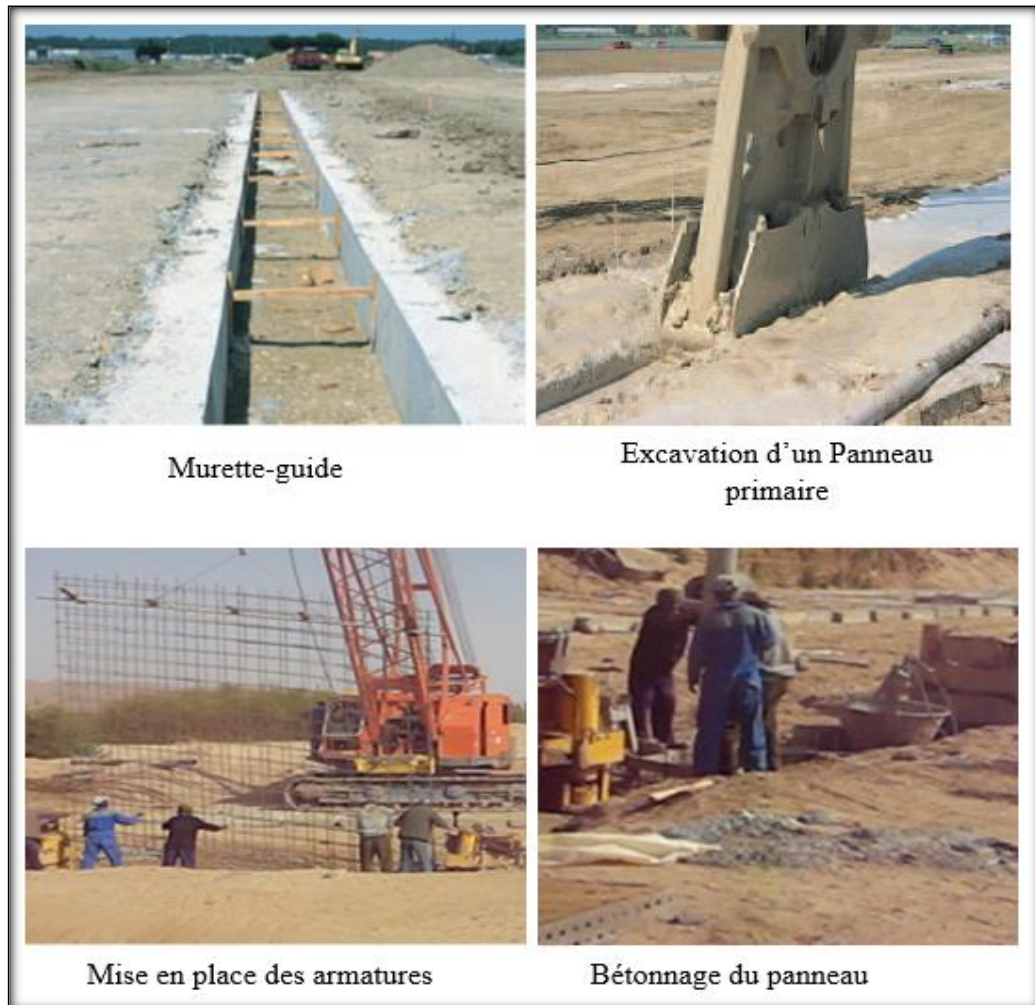
Figure I.41 : La réalisation d'une paroi moulée en béton
