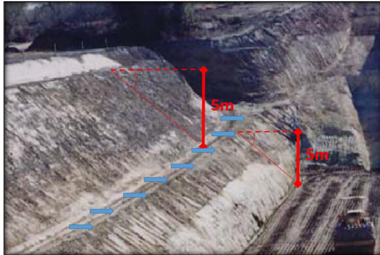
Figure 1.8 : Les étapes d'excavation
