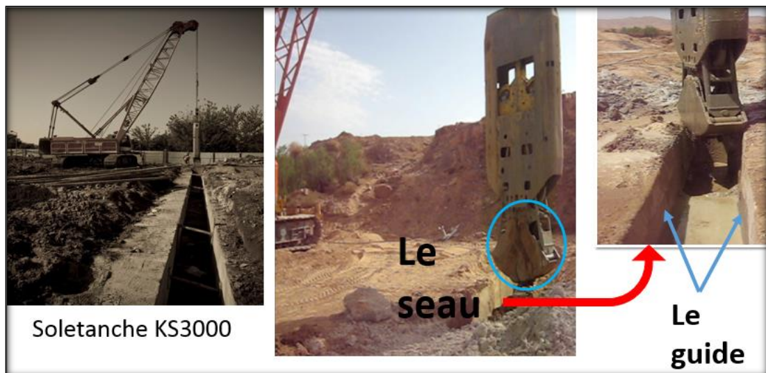
Figure I.25 : L'excavatrice de mur de diaphragme de seau
