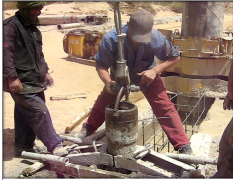
Figure I.26 : Remplissage d'excavation par la boue auto-durcissant
