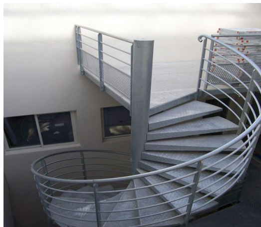
Figure 2. 6: escalier en charpente métallique
