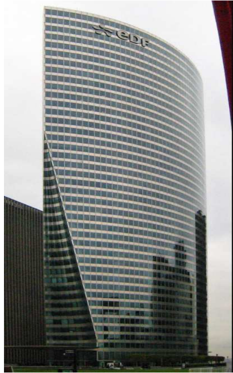
Figure I-15 : Bâtiment réalisé avec un béton à hautes performances (BHP) (Tour EDF Paris)
