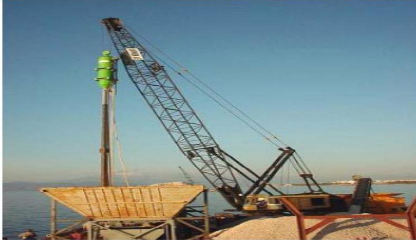
*Figure III.12: Atelier de réalisation de colonnes ballastées (Document de Soletanche Bachy)*
