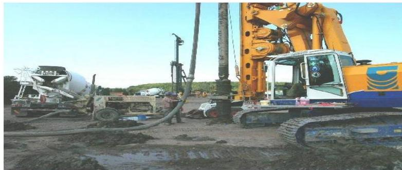
**Figure II.13 :** Chantier de réalisation des Colonnes à Module Contrôlé (I.ZIGHMI et CH. Messis. 2008).
