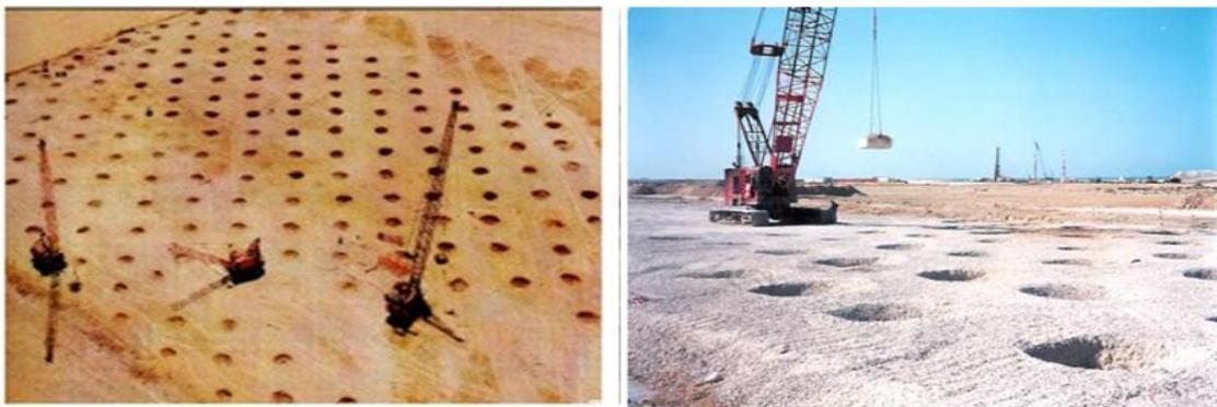
**Figure II.5 :** chantiers de compactage dynamique (B .ZIGHMI I.2011).
