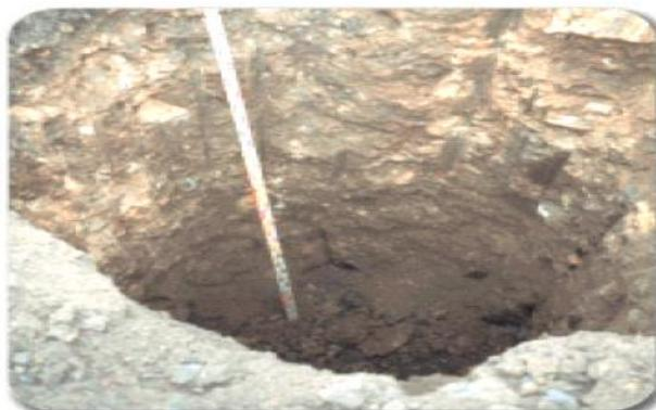
**Figure III.16 :** Plot ballasté avant remblaiement type. (A.NOUI, 2012).
