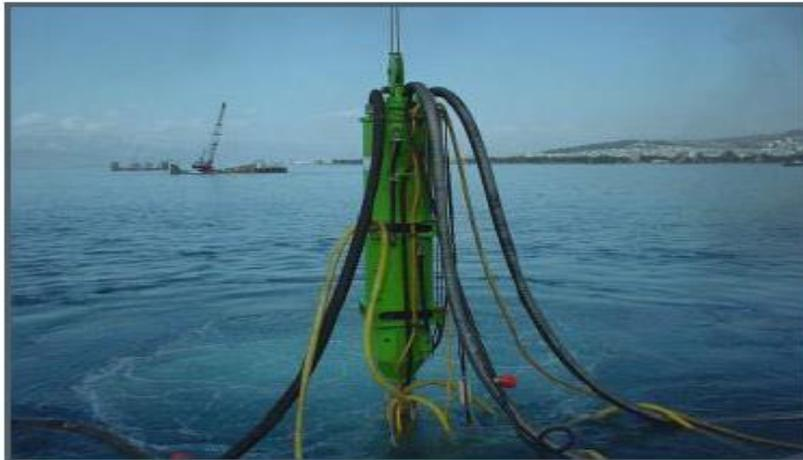
*Figure III.13: Exemple d'un système en double sas (Document de Soletanche Bachy)*
