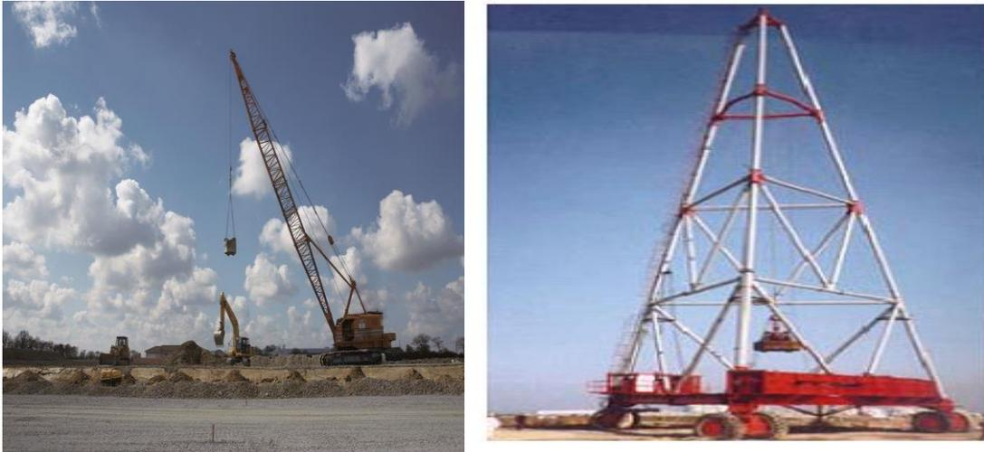
**Figure III.14 :** Engin utilisé pour la réalisation des plots ballastés (Document de Ménard Sol traitement®)
