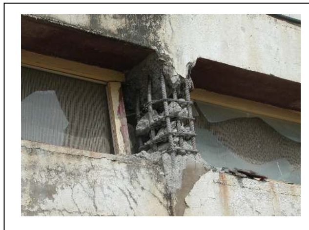
Figure II.5 : Exemple d'un poteau court [03].
