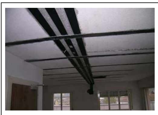
Figure II.30 : Bandes de renforts en sous face d'une dalle Figure II.31 : Bandes de renforts autour d'une trémie [14]
