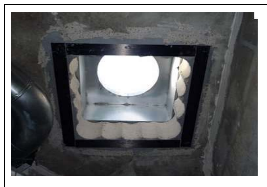
Figure II.30 : Bandes de renforts en sous face d'une dalle Figure II.31 : Bandes de renforts autour d'une trémie [14]
