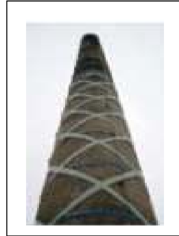
Figure II.27 : Renforcement d'une Cheminée par des bandes [14]
