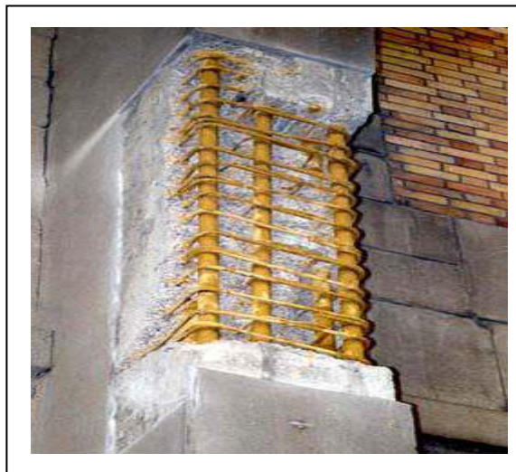
Figure II.7 : Réfection des bétons et protection des armatures [04].
