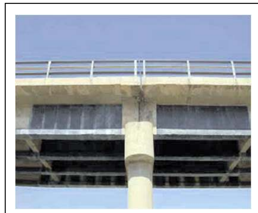
Figure II.40 : Application de la colle structurale sur l'interface [19].
