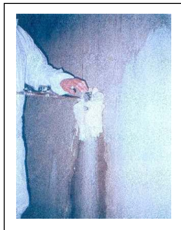
Figure II.13: Injection de résine polyuréthane [03].
