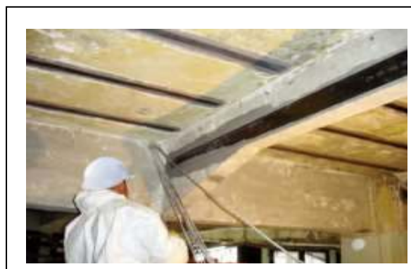
Figure II.28 : Mise en œuvre de bandes de renfort en sous face d'une dalle et sur des poutres [14]
