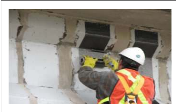
Figure II.26 : Mise en oeuvre de bandes de renforts sur un pont [14]
