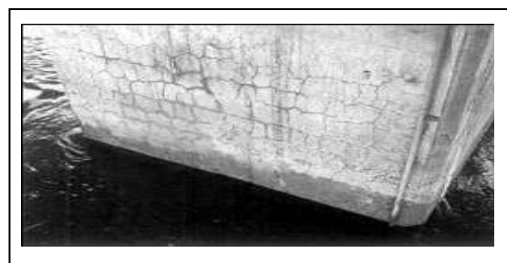
Figure II.4 : Principe de la réaction alcali-granulats résultant en des fissures dans toutes les directions [03].
