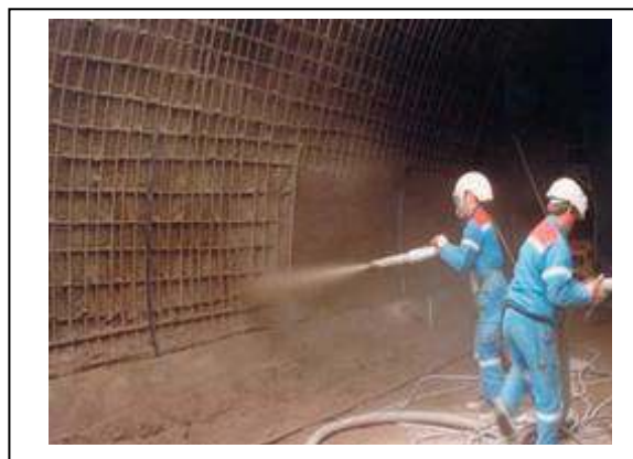
Figure II.10: Renforcement au moyen de béton projeté [04].
