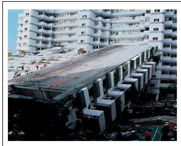
Figure II.6 : Renversement de bâtiments sous l'action sismique [03].
