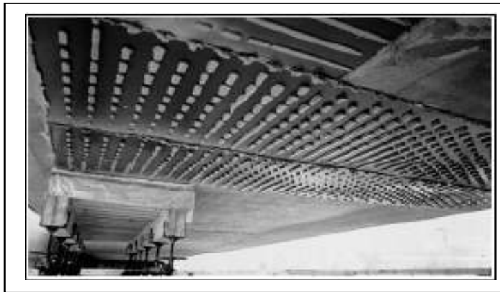
Figure II.11 : Renforcement d'un viaduc par tôles collées [08]
