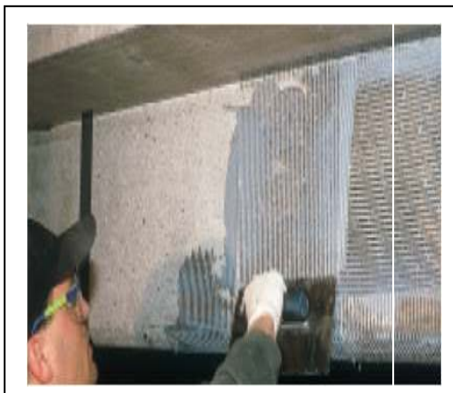
Figure II.40 : Application de la colle structurale sur l'interface [19].
