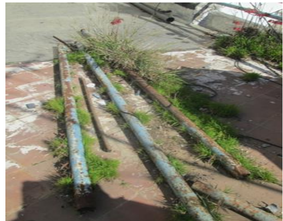
Figure 3.25 : Développement de végétation au niveau du revêtement de la terrasse
