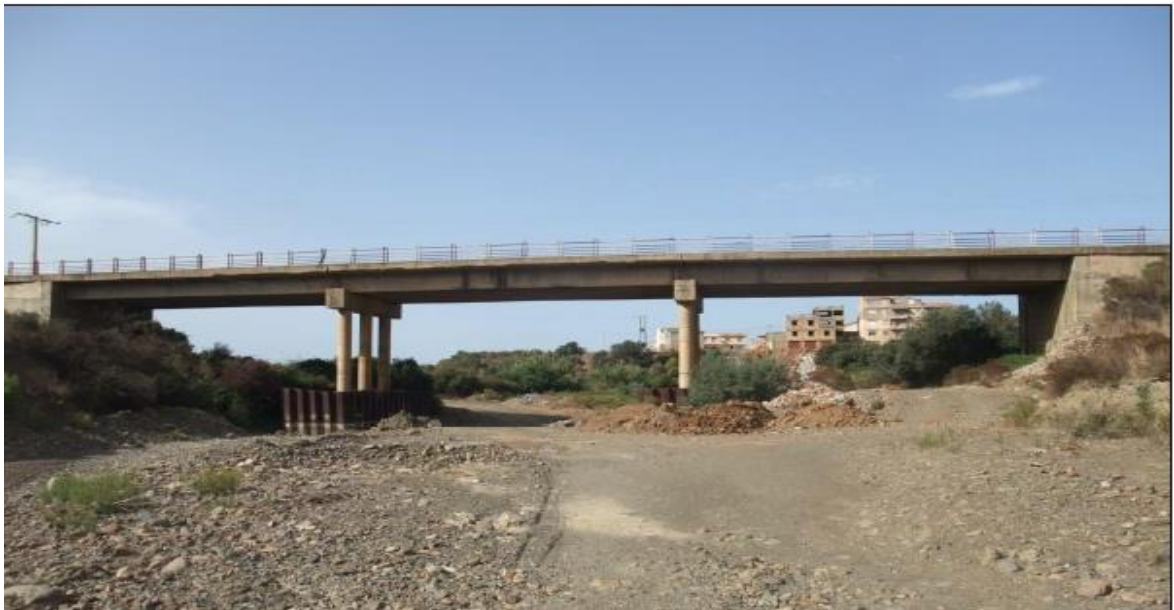
Figure 3.72 : Vue générale du Pont sur Oued Megoura, Béni Ksila, Bejaia.
