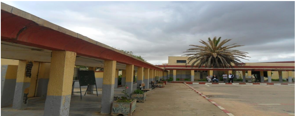
Figure 3.52 : Vue générale sur les galeries, Bou Ismail, Tipaza.
