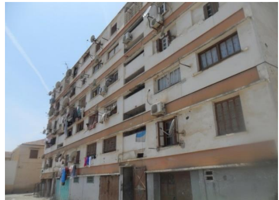
Figure 3.2: Vue du bâtiment B à trois blocs.
