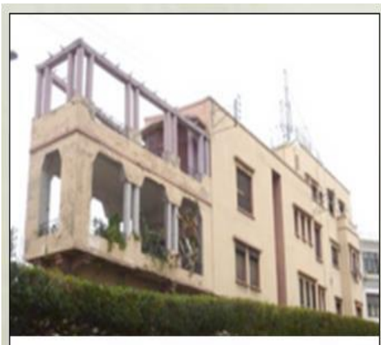
Figure 1.10 : Immeubles en béton armé, Alger, 1904
