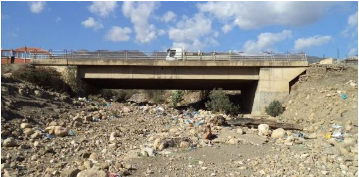
Figure 3.63 : Vue générale du Pont sur Oued Mechaab, Akbou, Bejaia.
