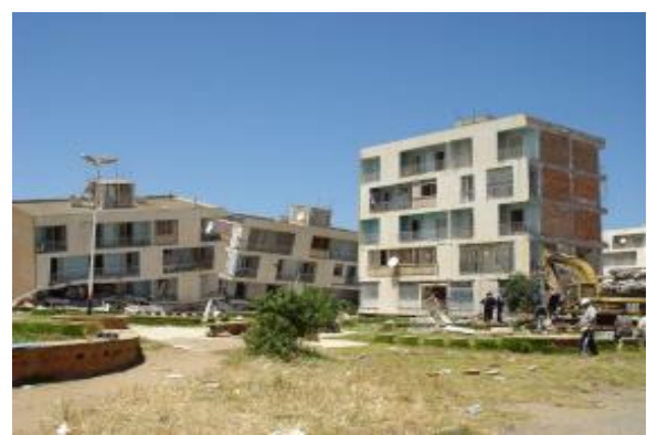
Figure 1.44 : Bâtiments avec poteaux, poutres et murs en maçonnerie, comportement aléatoire[48].
