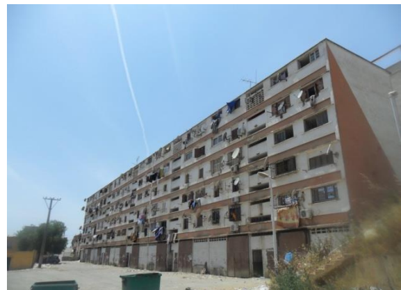
Figure 3.4: Vue du bâtiment D à cinq blocs.
