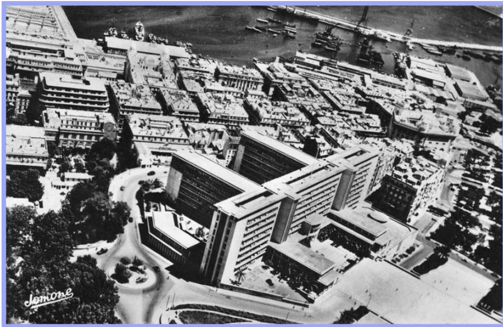
Figure 1.14 : Vue aérienne « Palais du Gouvernement actuel» Alger, 1930[17, 20].
