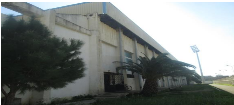
Figure 3.56 : Vues d'ensemble de la tribune du coté intérieur et extérieur du stade.
