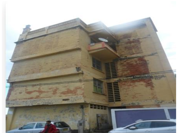
Figure 3.40 : Maçonnerie extérieure en briques pleine perforée.
