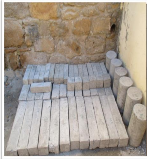
Avant la réparation
