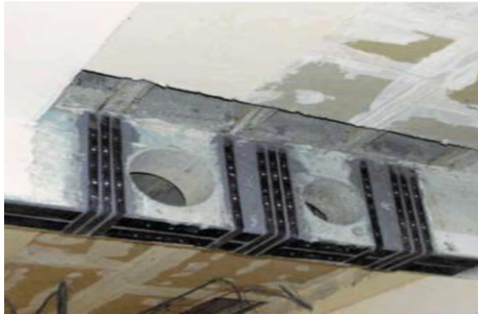
Figure 2.12 : Renforcement d'une poutre par TFC [58].
