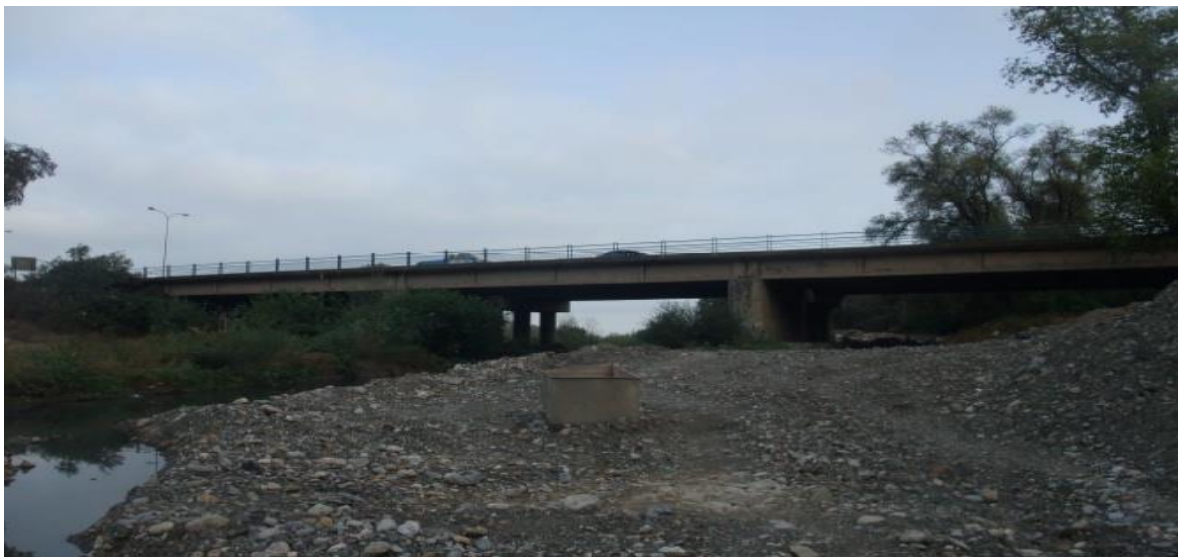
Figure 3.81 : Vue générale du Pont sur Oued Djmaa, Aokas, Bejaia.
