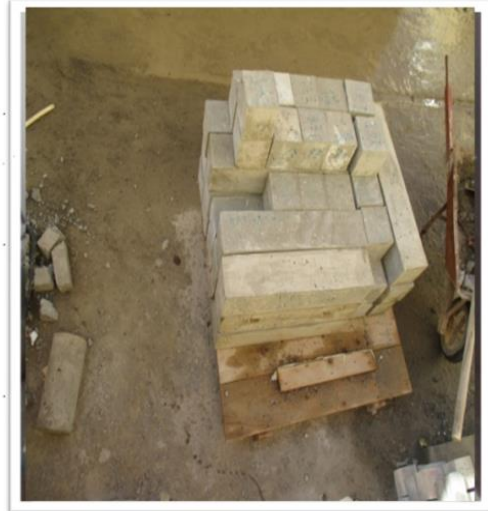
Après la réparation
