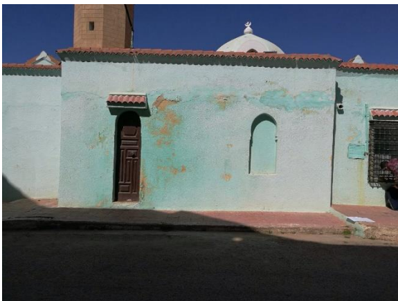
Photo 04 :vue sur la façade sud-est de la mosquée Source : auteur
