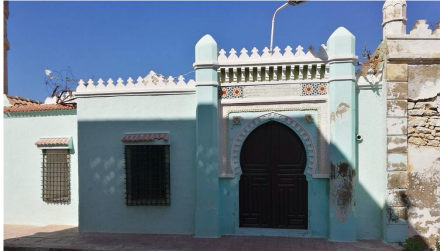
Photo 06 : vue sur la façade sud-est de la mosquée Source : auteur
