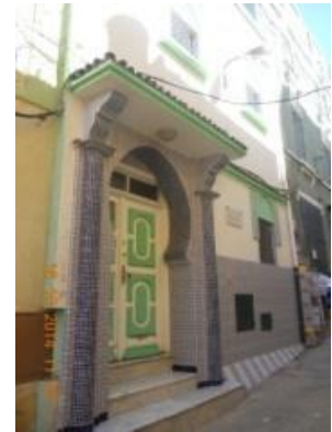
figure117 : la mosquée sidi yahia
