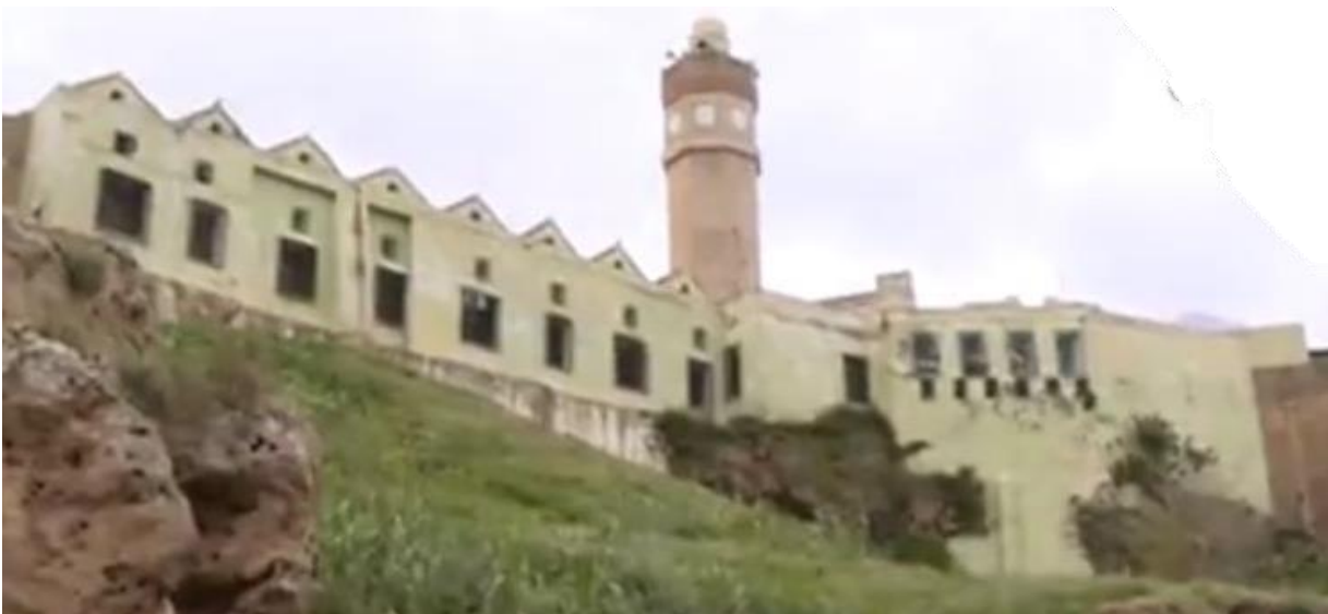
Photo 07 : vue sur la façade nord-ouest de la mosquée Source : auteur
