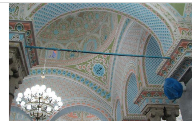
figure 98 : la coupole de la mosquée Salah Bey
