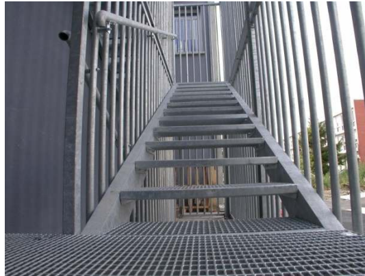
Figure IV.15 : escalier métallique droit (caillebotis).
