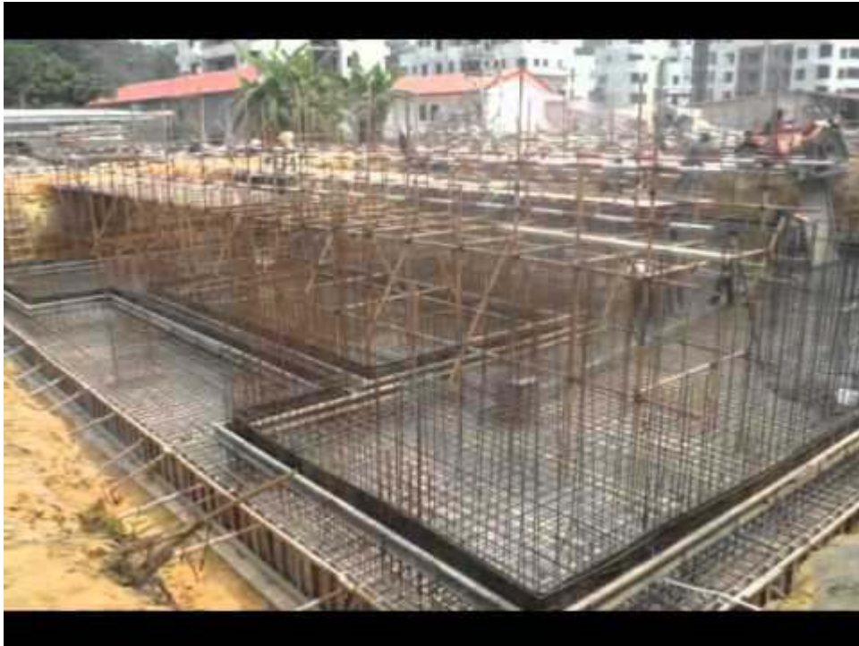
Figure IX.1 : ferrailage d'une infrastructure
