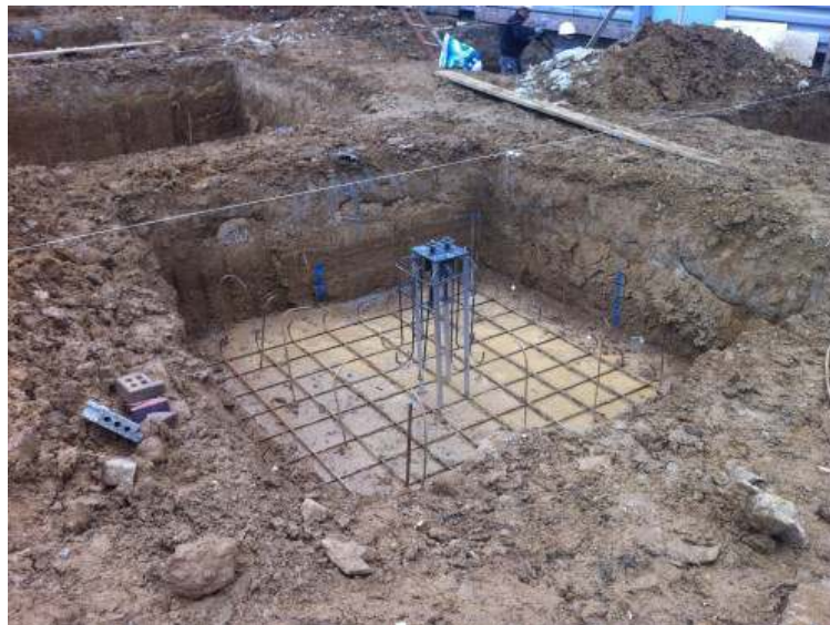
Figure IX.2 : assemblage pré scellé (avant coulage du béton)
