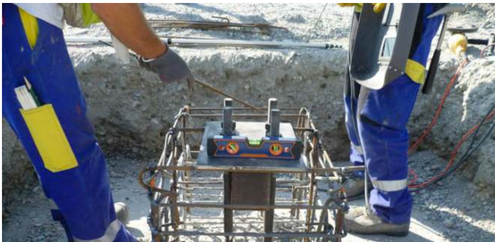
Figure IX.3 : assemblage pré scellé (avant coulage du béton)
