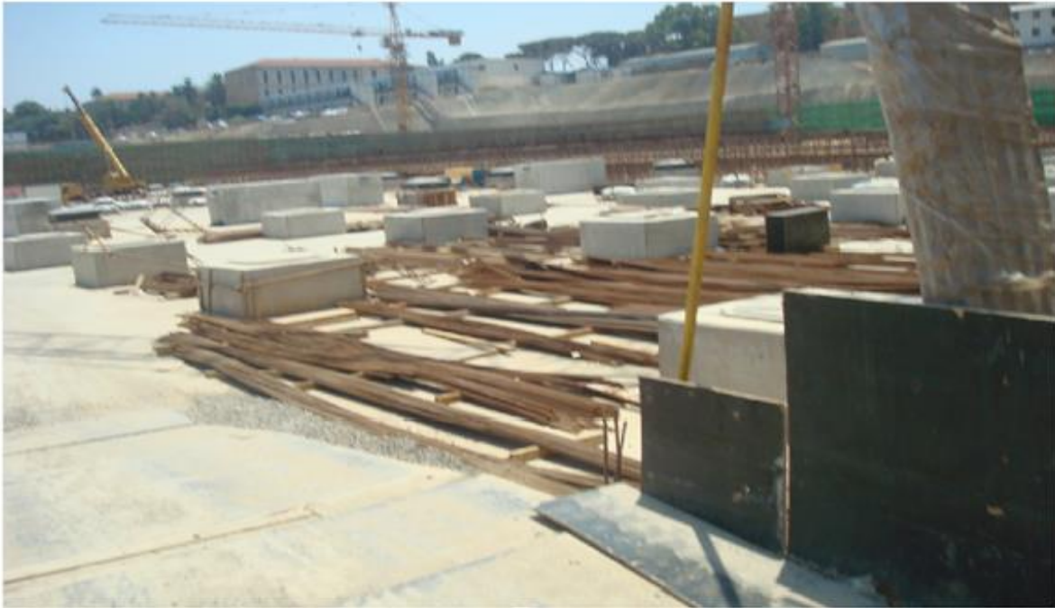
Figure 2.17 : Socle en béton posé sur radier conçus et réalisés spécialement pour les appuis à glissement (grande Mosquée d'Alger)
