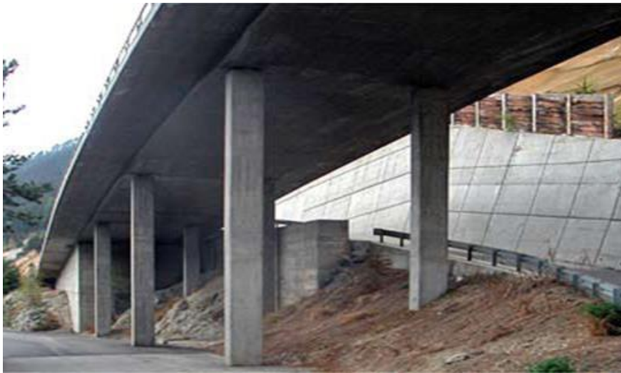
Figure 2.8 : Isolateurs utilisés au niveau des poteaux élancés des ponts
