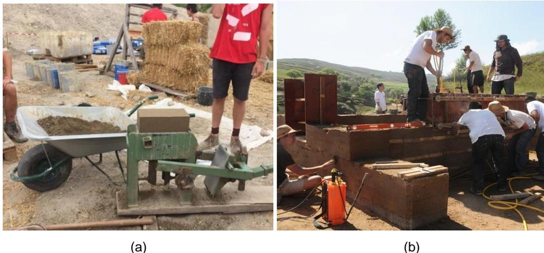
**Figure 3.4** : Techniques de construction en terre à l'état humide. (a) : BTC, (b) : Pisé [209, 211].
