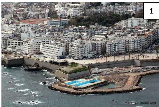
Figure 6: Vue sur les piscines de Beb el oued .
