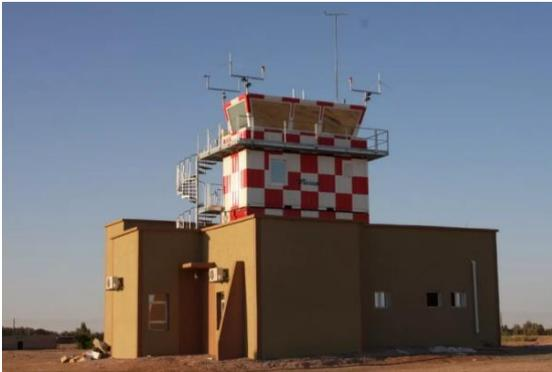
**Figure 2.14 :** Balisage diurne d'un Obstacle massif [18].
